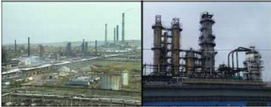
Ангарский Электро Химический Комбинат (АЭХК, Ангарск, Иркутская обл.)
